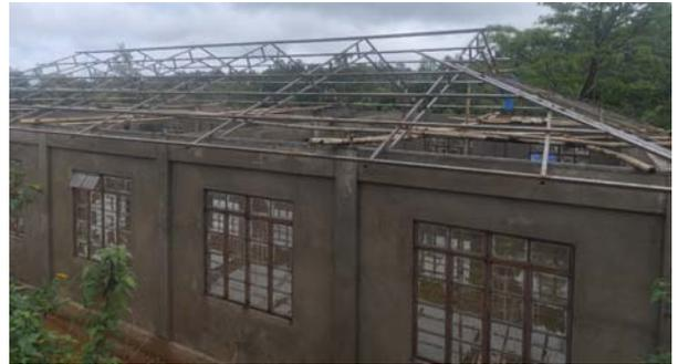
Mit Spannung schauen wir auf unser **Kurkuma-Projekt in Thadsning**. Die Halle steht bereits und die Dachkonstruktion ist abgeschlossen. Wenn – abhängig von der seit Mitte Mai einsetzenden Regenzeit – das Dach fertig gestellt ist, können die Innenarbeiten und die Ausstattung mit den Verarbeitungsmaschinen begonnen werden.
